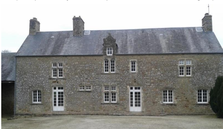
La façade a gardé son aspect originel, avec ses fenêtres à meneaux et en particulier le fronton original de la lucarne.
