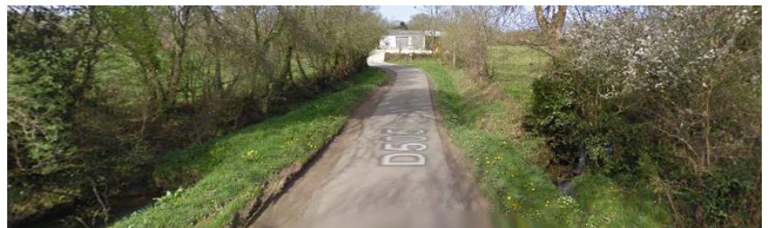
Pont de Néretz (D505)
