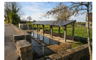
rue de la Trainellerie - D 265
