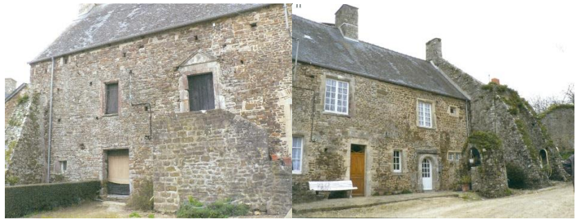
Parties gauche et droite du logis (façade avant)
