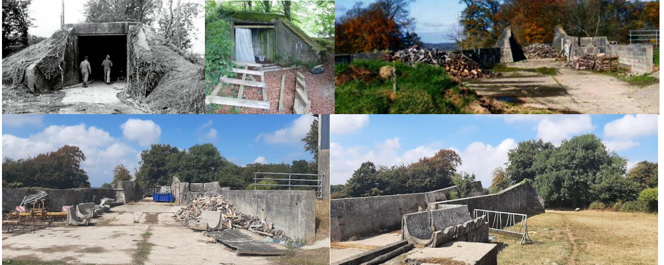
Vestiges de la rampe chemin du moulin
