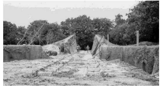
Cette photo montre les murs protecteurs de la rampe.
