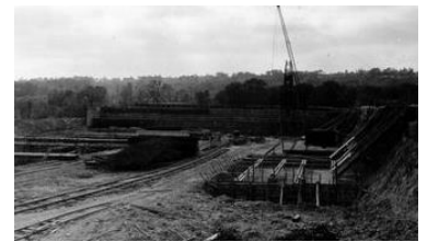
Bunker en construction pour lancer des V2, le RLW de Sottevast-Brix
