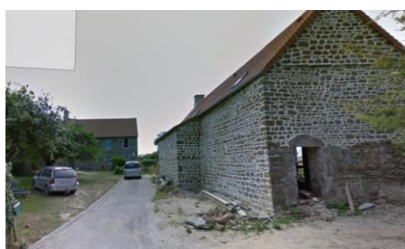
La grange en cours de restauration
