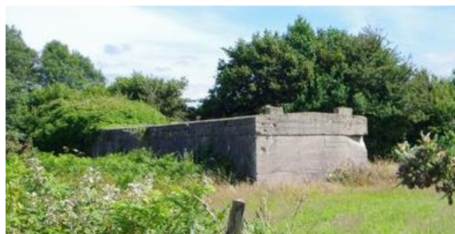
Bâtiment de stockage de V1
