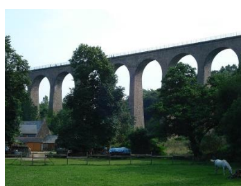
Viaduc de Fermanville
