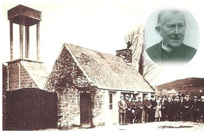
Le pavillon « thermal » (boulangerie) lors de l'inauguration
