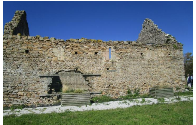
Cette chapelle se situe sur un terrain privé
