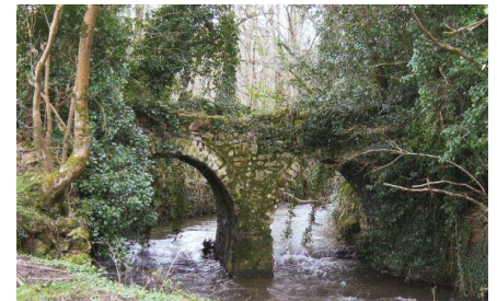
Pont Saint Simon situé à 200 m du château sur un bras de la Douve
