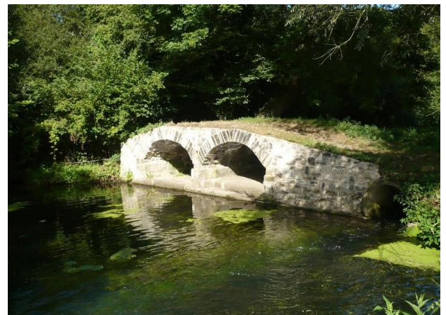
Le pont romain sur le Merderet
