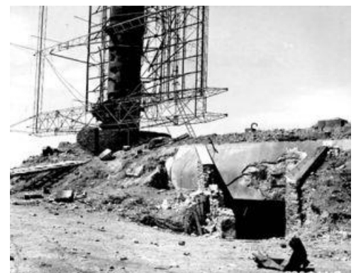
Batterie d'Osteck avec son radar pour protéger l'aérodrome de Maupertus
