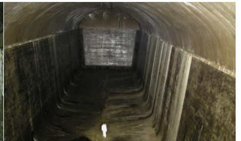
Entrée de la galerie du complexe et au fond un des huit réservoirs de 10 000 m 3 . Vue d'une cuve (le mannequin permet de se rendre compte du côté gigantesque de cette construction)
