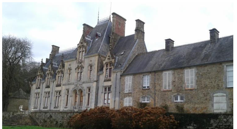
Façade arrière (Est)
