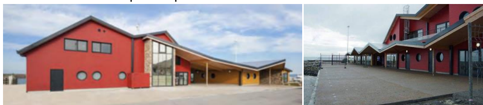
Bureau du port et la gare maritime
