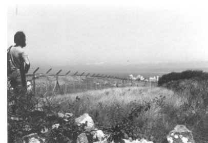
Des explosifs détruisent la falaise
