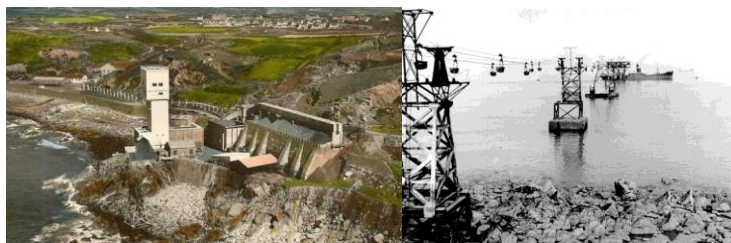
La tour d'extraction et les pylônes équipés de wagonnets
