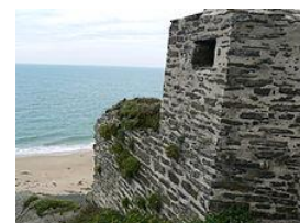
Entrée de l'ancien corps de garde de Carteret
