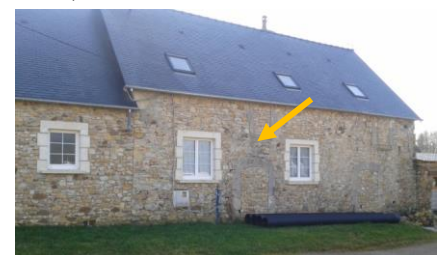
Anciennes dépendances transformées en habitation (traces des anciennes ouvertures)
