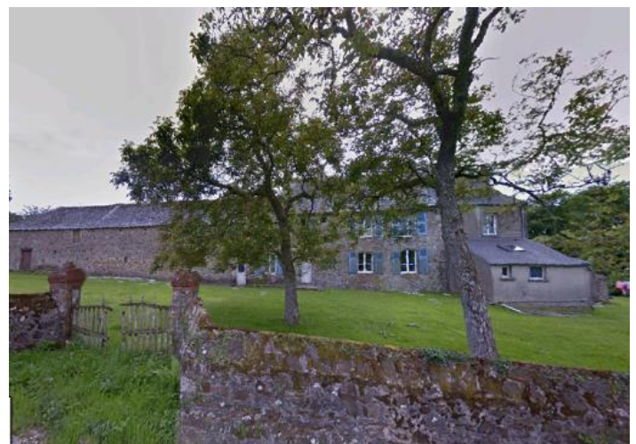
Vue arrière de la propriété avec l'ancienne entrée. L'entrée se trouve de l'autre côté à partir du chemin de travers
