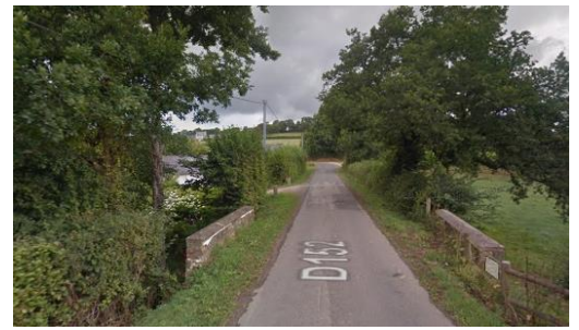
Pont du Vieux Moulin
