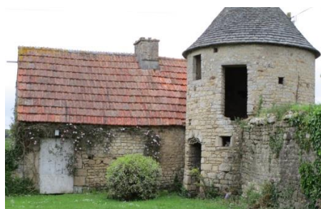
La petite tour le long de la route
