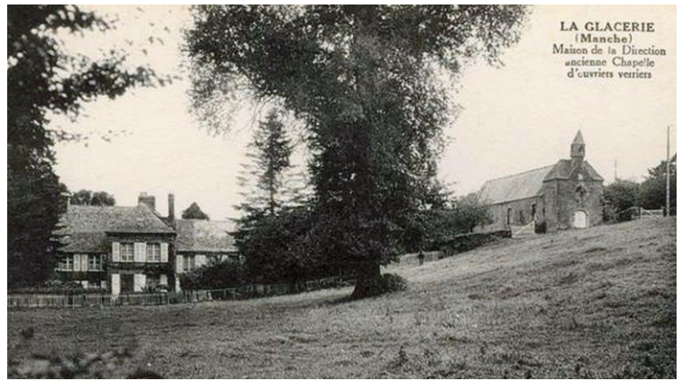
La maison de la direction et l'ancienne chapelle des ouvriers verriers
