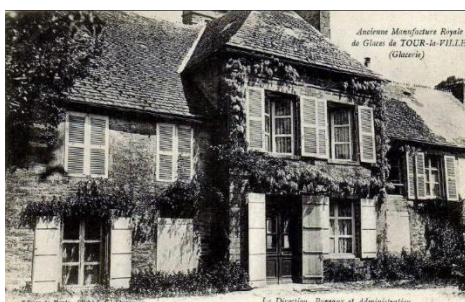
Bâtiment de la direction, bureau et administration
