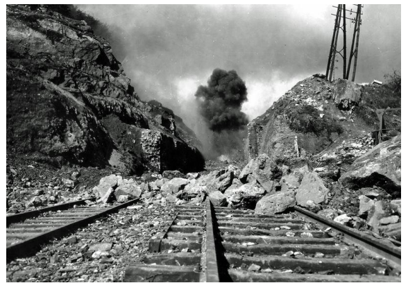
Ouverture de la tranchée à ciel ouvert
