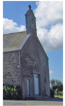
Le pignon sous le clocheton était percé de deux baies en ogive qui ont été bouchées alors qu'une petite porte fut ouverte sous celle de gauche
