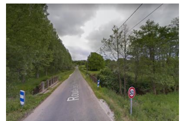
La Gloire / Pont du Planchon
