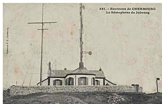
A l'origine, la station comprend deux chambres (une pour chaque guetteur), une cuisine et une chambre de veille. La chambre de veille est traversée par le mât sémaphorique. Ce mât comporte 3 ailes et un disque au niveau supérieur. A chaque position de ces trois ailes et du disque correspond un mot ou une phrase conventionnelle. La station peut ainsi communiquer avec les navires en mer. Y sont affectés un guetteur et un guetteur chef civils, logés avec leur famille.
