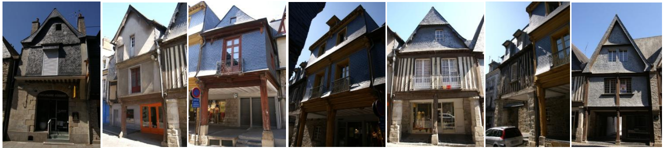
Les maisons en pan-de-bois à porche (XV e -XVI e ), situées aux n° 6, 8 et 10 rue de la Poterie. Les porches appelés "les Grandes Porches" filaient sur tout le côté de la rue jusqu'à la rue de La Baudrairie.
