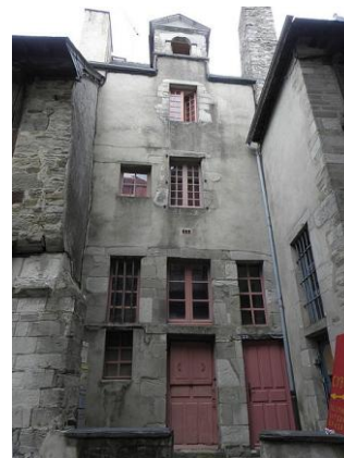
maison (XVI e ), située au n° 23 rue de la Baudrairie
